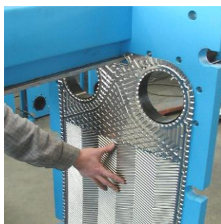
Рис 6.11. Монтаж первой пластины
